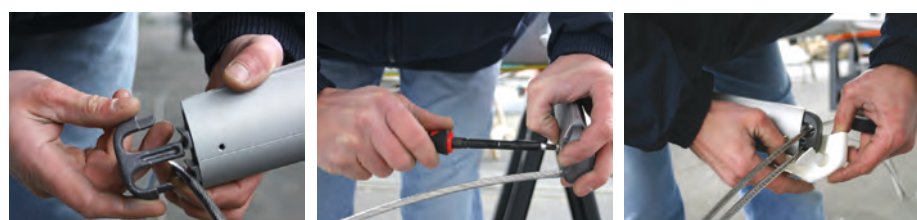
Vérifier le positionnement des câbles avant fixation des embouts de BDF
